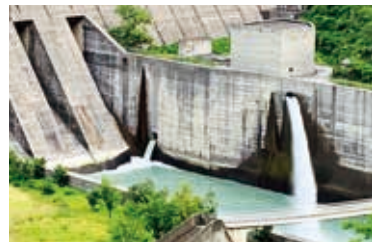
4.51m 3 /秒が長島ダムから放流。(6月10日) 大井川ダムの「清水化バイパス」へ。
