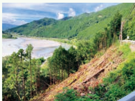
伐採された県道77号の下斜面
