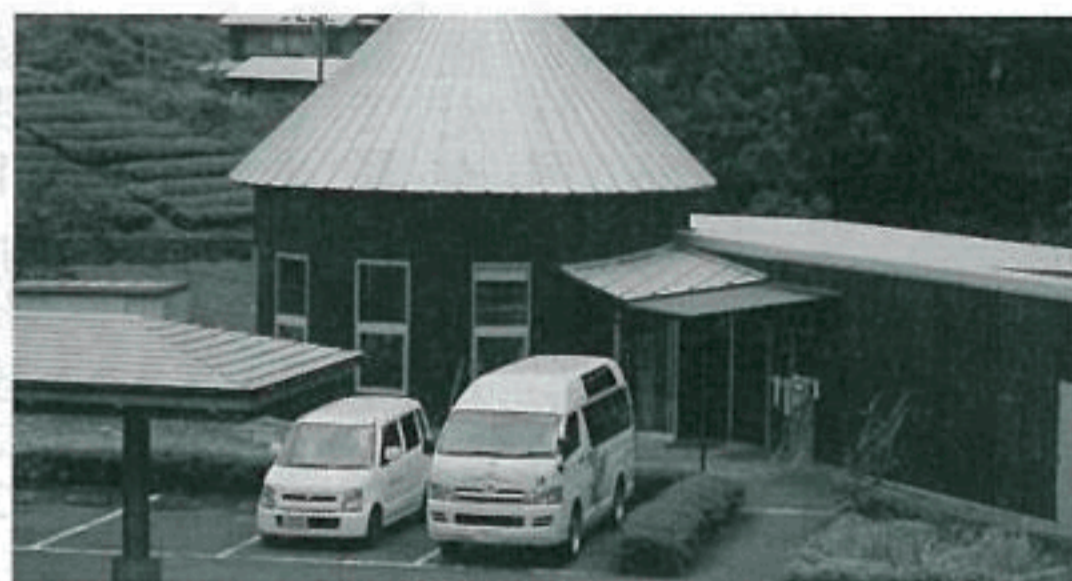
本川根作業所全景
