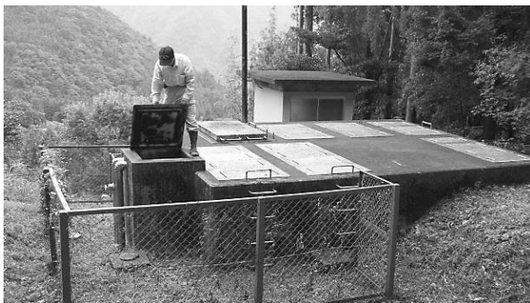
向井飲料水供給施設
