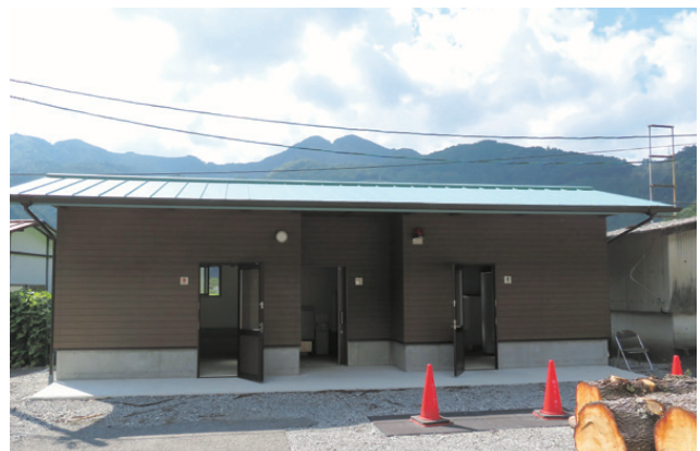
貯木場トイレ (桑野山)
