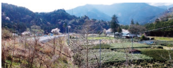
青部バイパストンネル工事土捨場
