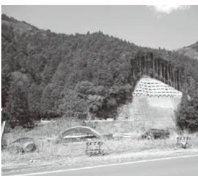
国道362号・復旧現場(水川地内)
