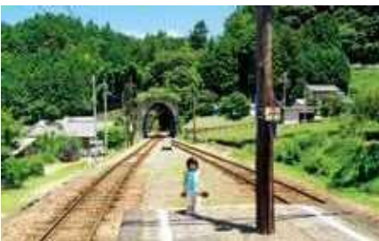
日本一短いトンネル (保安)
