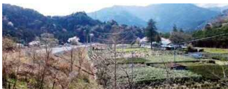
青部バイパストンネル工事土捨場
