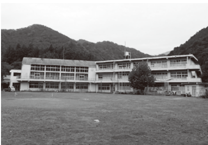
今後の活用が期待される 旧本川根北小学校（奥泉）
