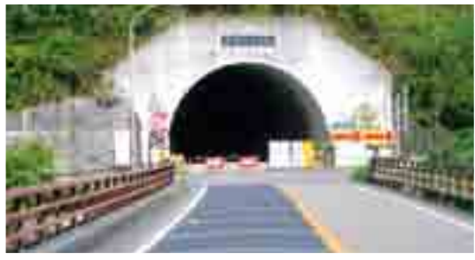
<R362馬路橋より馬路トンネル>
