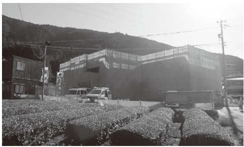
◀完成に向けて工事が進む若者交流センター「奥流」
