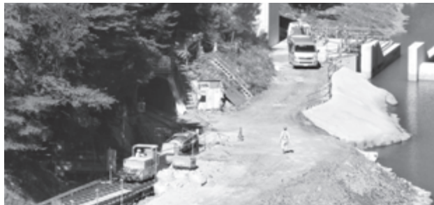
清水工事状況
