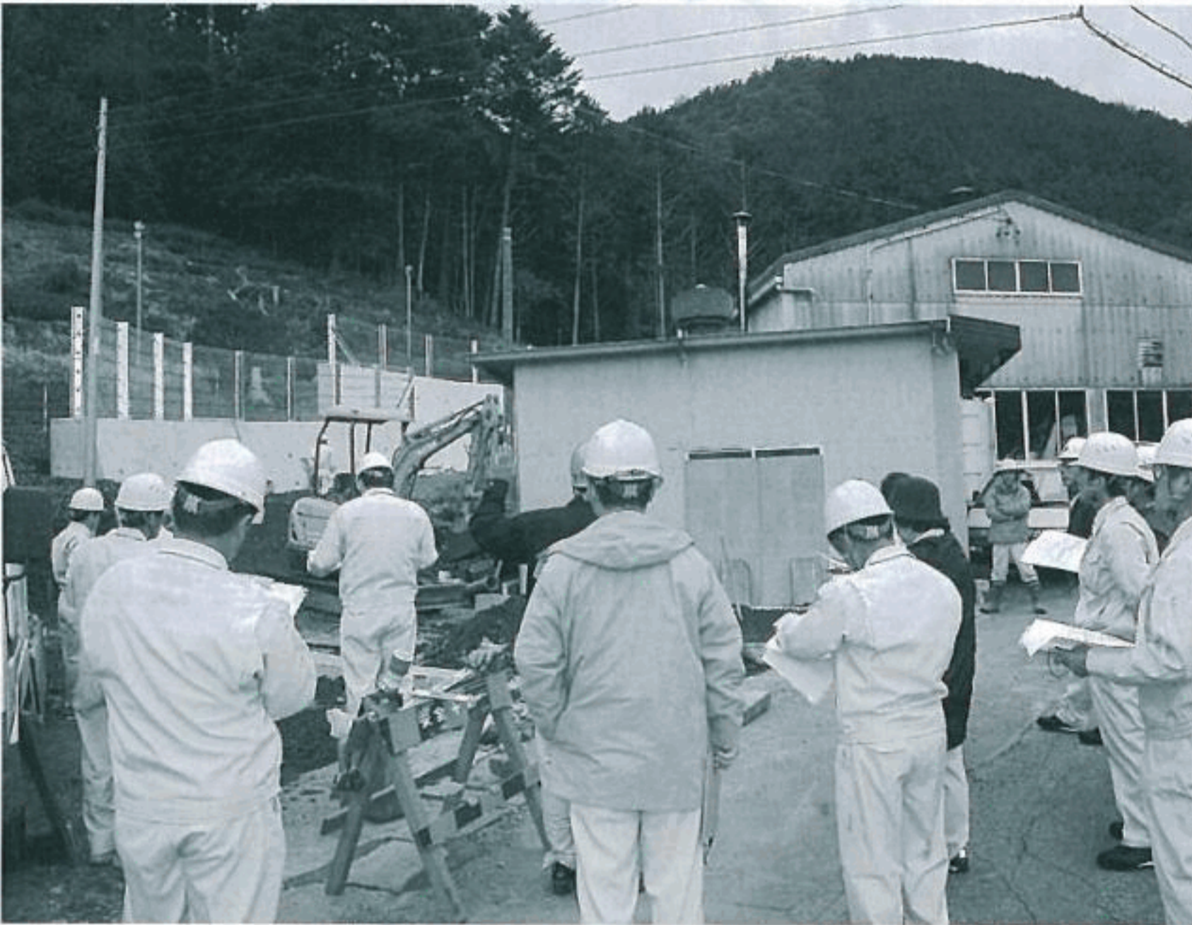
三津間地区 急傾斜工事現場
