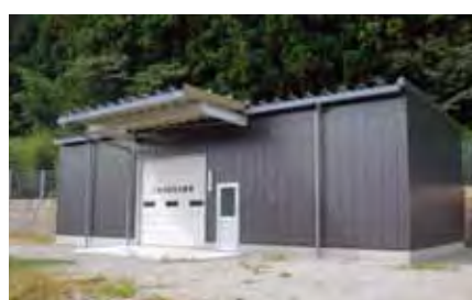
高郷にある町の防災倉庫
