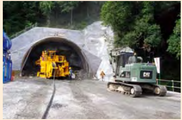
トンネル工事に着工
