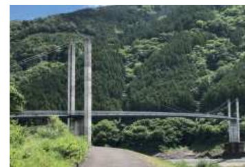
▲南アルプス接岨大吊橋
