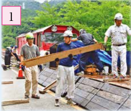
1 アプト式列車から木材をおろす様子 2 降ろした木材をウッドデッキ設営場所まで運ぶ様子 3 ウッドデッキ設営場所骨組み
