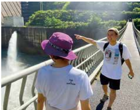
長島ダム「しづき橋」で
