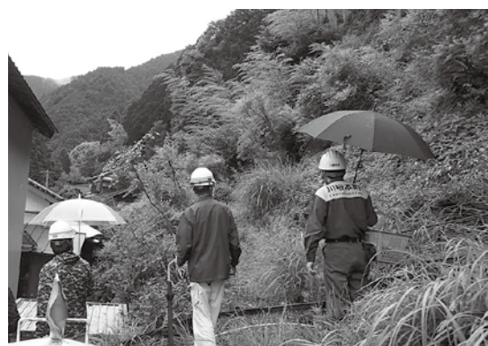
崩壊する危険性の高い斜面を確認
